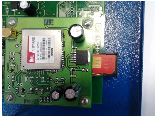
Фото 12.1. Установка лотка на место
